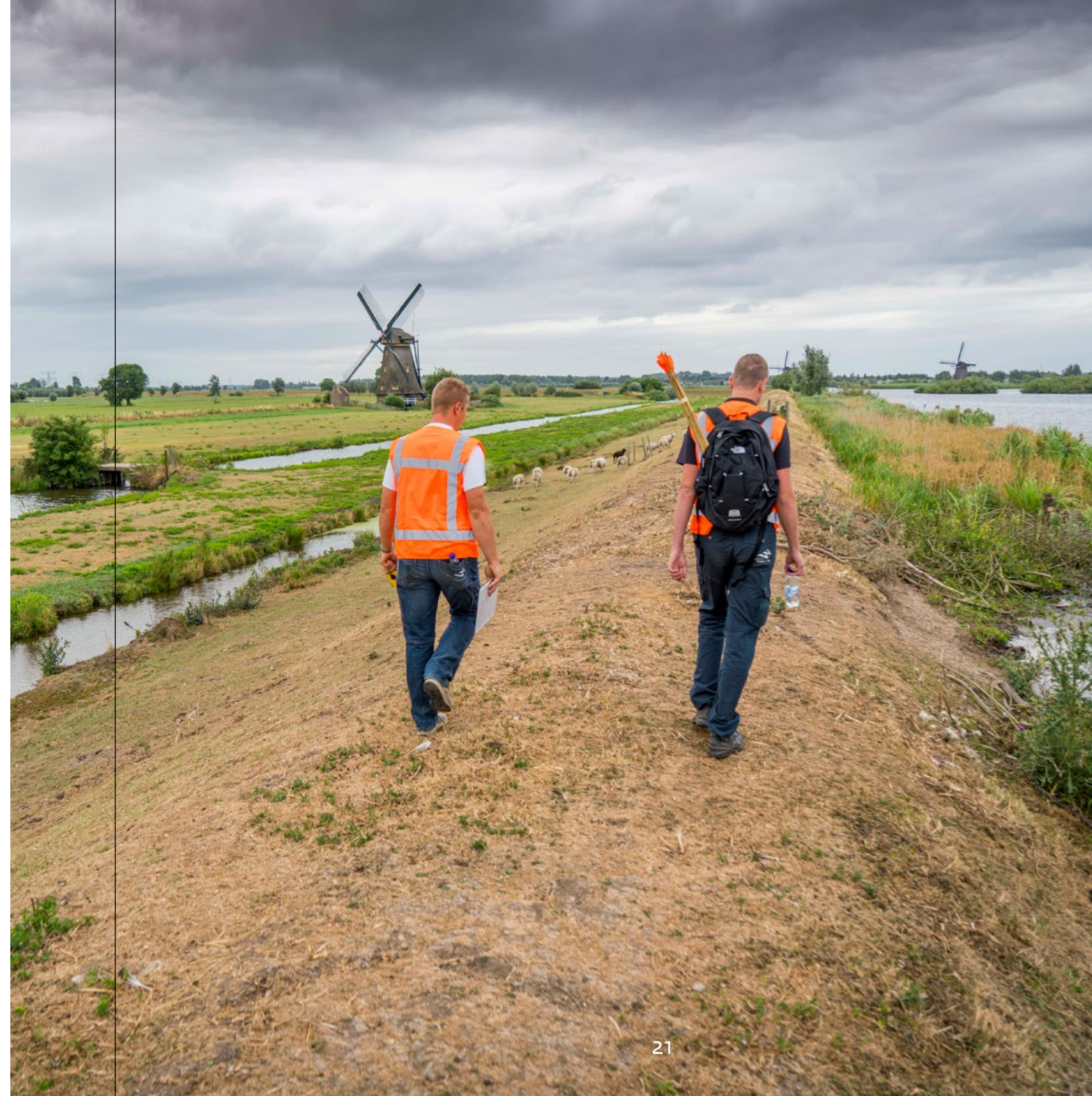
Dijkinspectie door Waterschap Rivierenland op een regionale waterkering bij Kinderdijk. In dit geval werd de dijk gecontroleerd op de aanwezigheid van scheuren door droogte.
