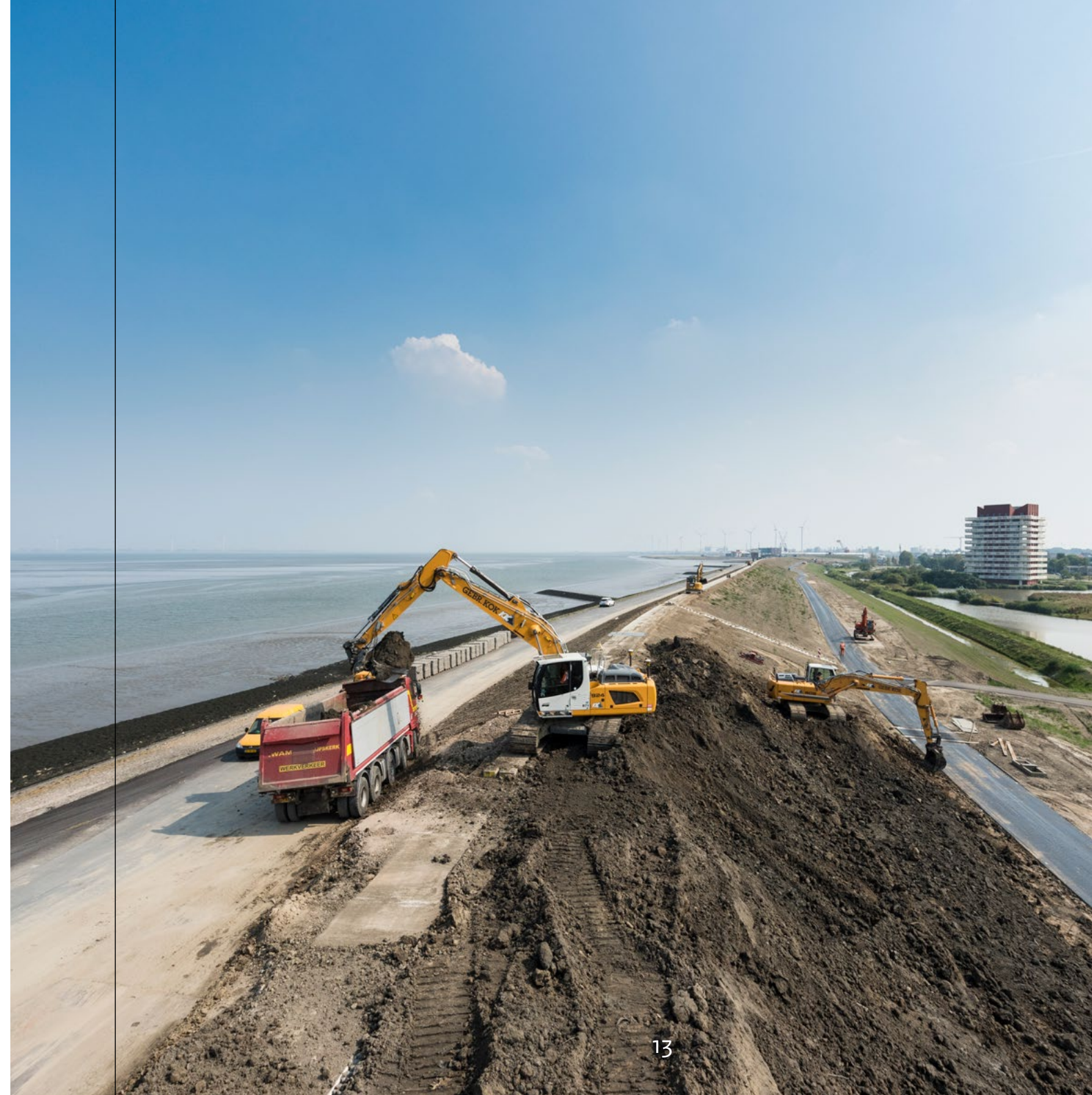
Dijkversterking in uitvoering (2019). De zeedijk bij Delfzijl werd hoger en breder gemaakt en aan de zeezijde versterkt met asfalt en betonblokken. Daarmee is de dijk bestendig tegen aardbevingen.
