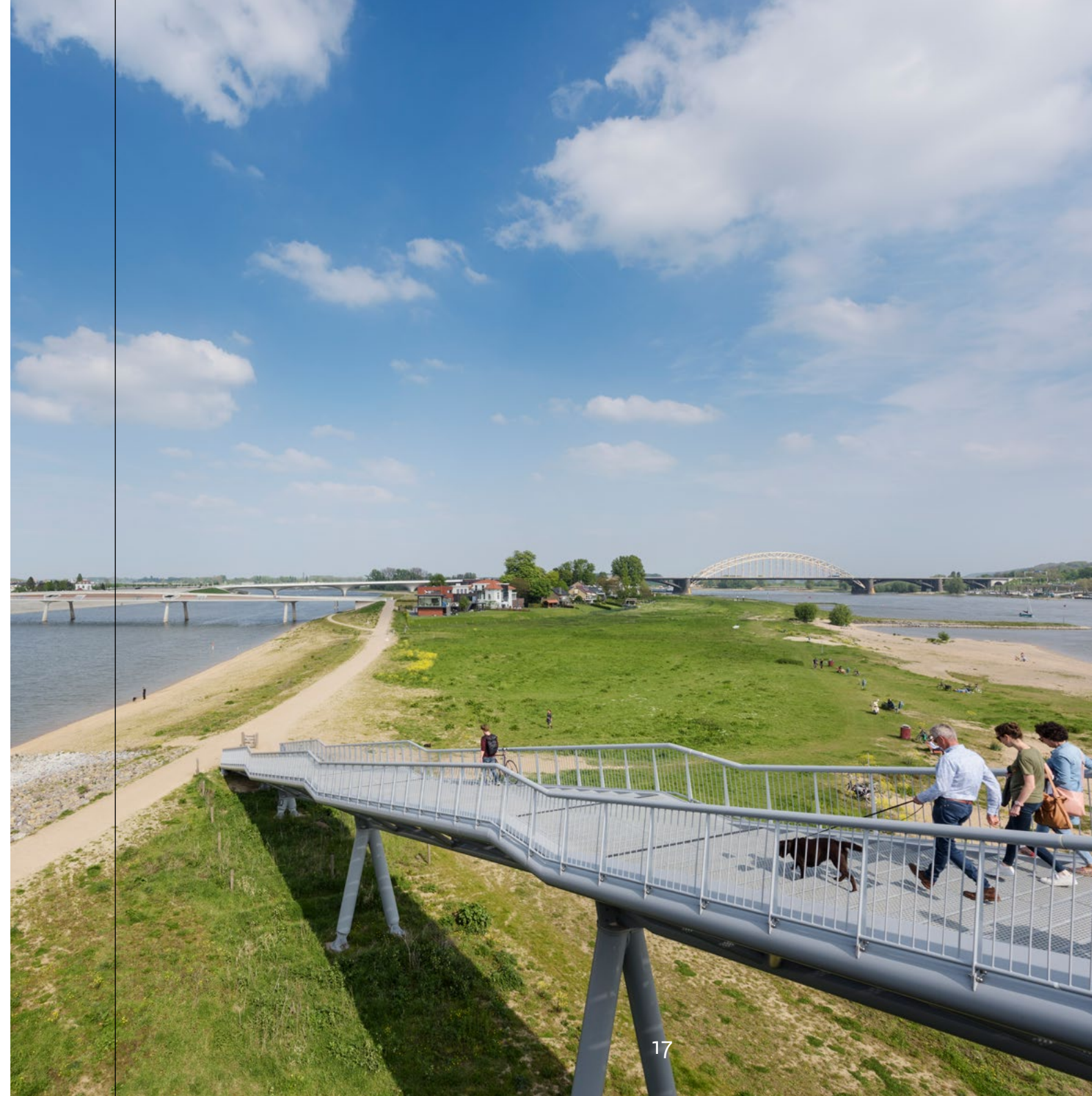
Voorbeeld van een Ruimte voor de Rivier-project: de nevengeul bij Nijmegen-Lent. Bij hoogwater zorgt de nevengeul ervoor dat de waterstanden minder hoog oplopen. Rond de geul en het ontstane eiland is een recreatiegebied ontstaan.
